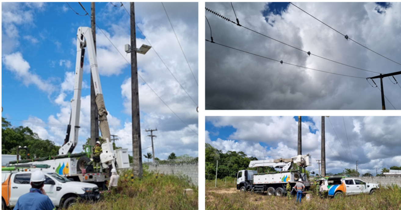
Figura 12 - Trabalhos de instalação do GODEL Smart Sensor em 138 kV
